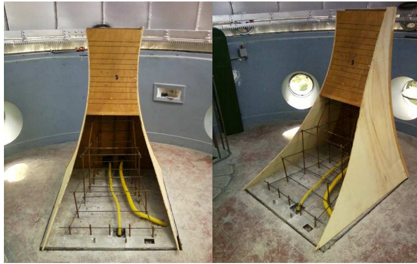
Fig. A-II.6: Molde já posicionado sobre a estrutura de reforço.
