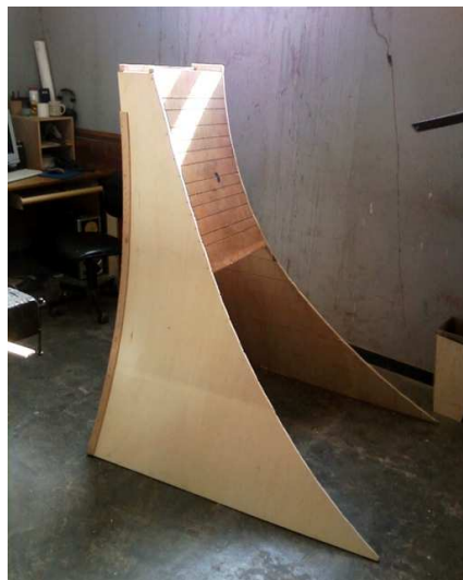
Fig. A-II.5: Molde em madeira do pilar.
