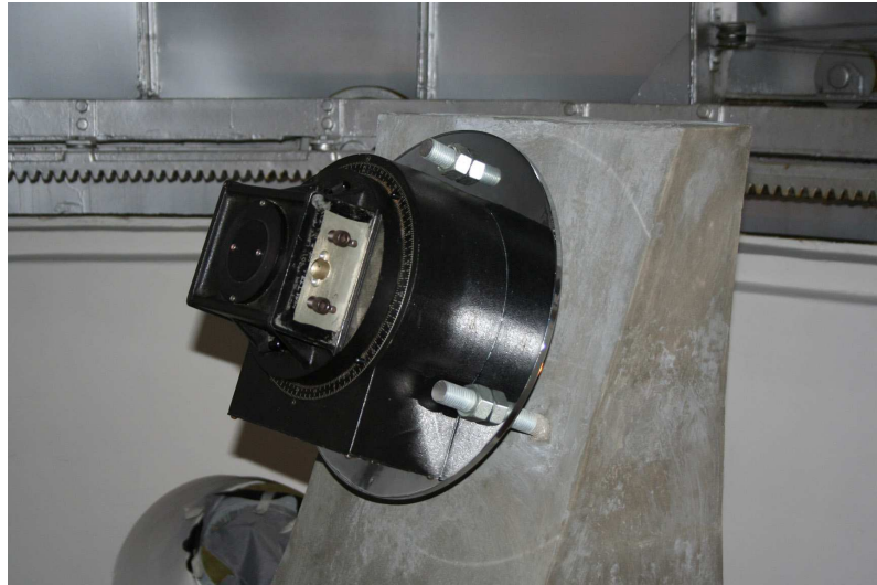
Fig. A-II.12: Base da montagem e placa suporte fixadas ao pilar.
