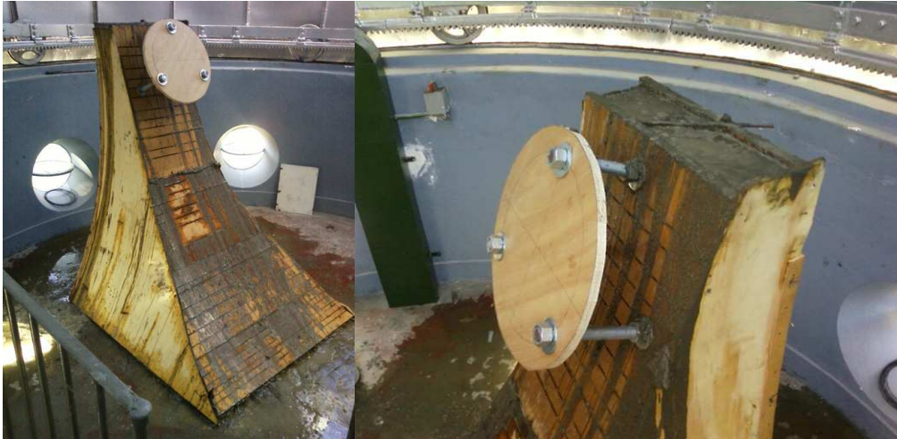
Fig. A-II.10: Molde completamente preenchido por concreto.
