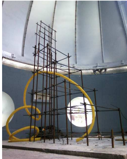
Fig. A-II.4: Foto da estrutura de reforço do pilar.
