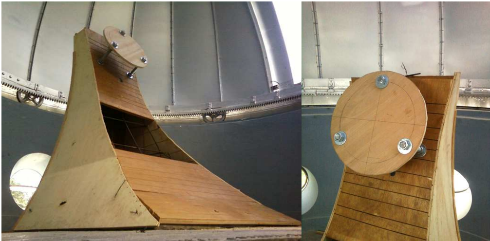
Fig. A-II.8: Gabarito de posicionamento das barras rosqueadas e a parte de baixo do molde fechada.
