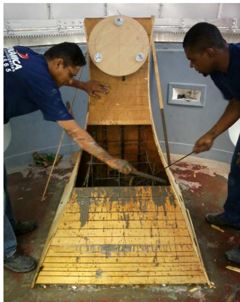
Fig. A-II.9: Aplicação da primeira camada de concreto.
